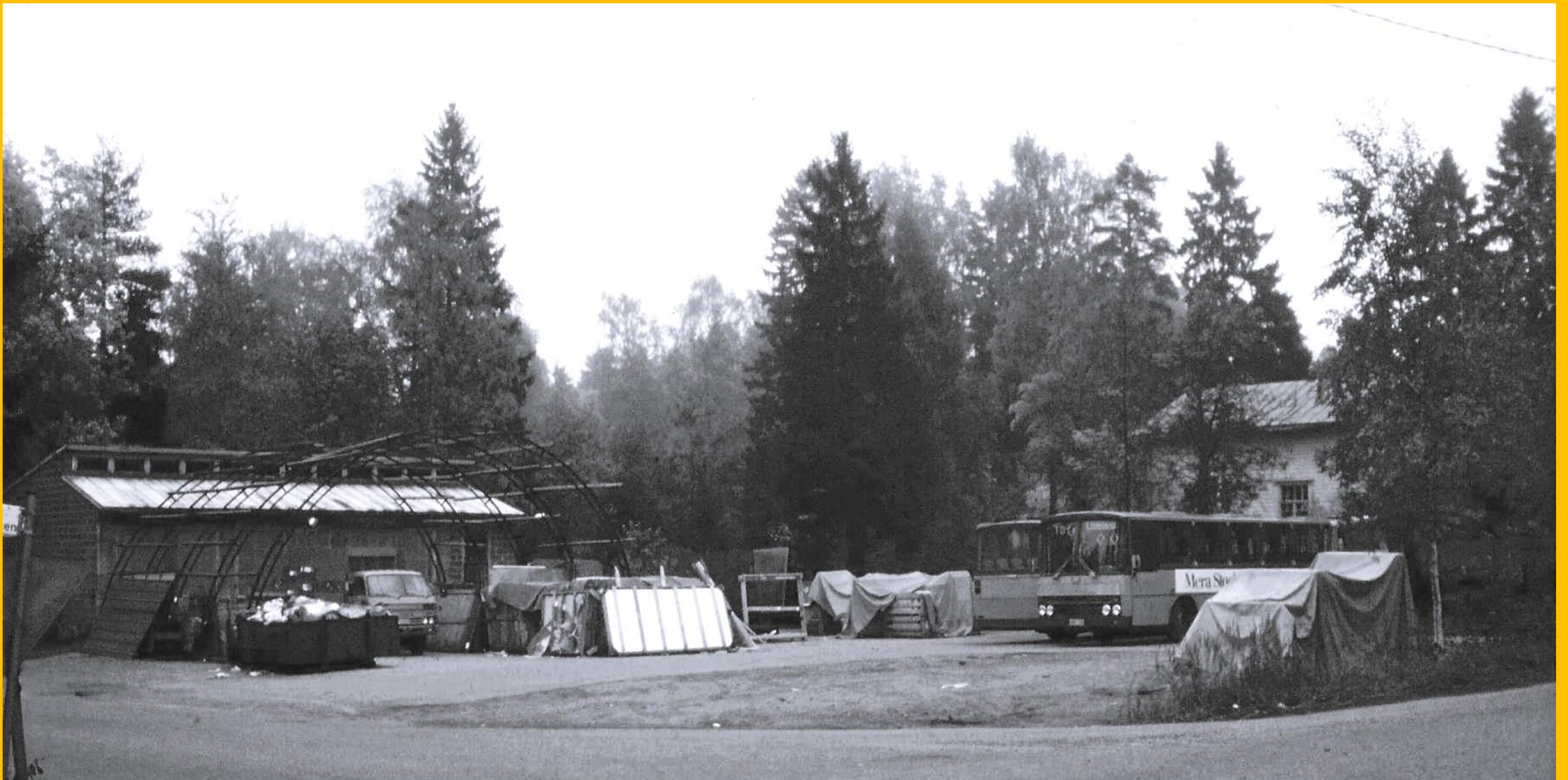
Leppävaaran Liikenne Oy:n 1957 hankkima palsta Lintuvaarantie 39, jolla sijait्सivat yhtiön tallit, huoltoasema ja toimisto. Toimisto oli takana näkyvässä Kallion huvilassa. Bussien huoltotilat ja kuljettajien taukotilat parakissa, jonka yhtiö rakensi. Kuva Markku Laine 1980-luku
